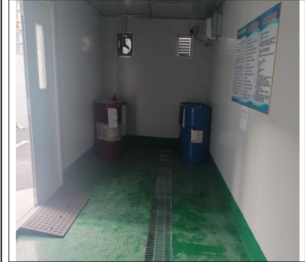
危废库地面防渗
